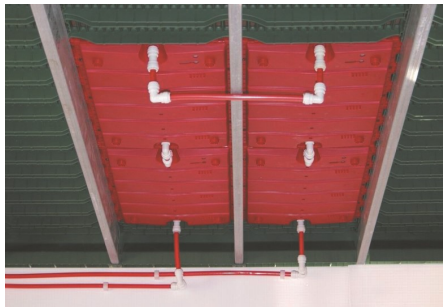
Abb. 12: Verbindung der Thermo W mit dem Stecksystem
