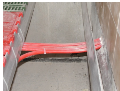
Abb. 13: Verlegung in den Kanal
